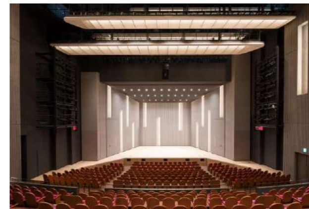
音響反射板を設置した舞台
