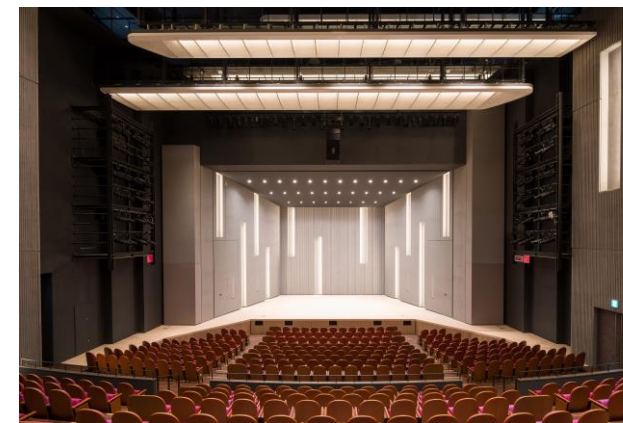
音響反射板を設置した舞台
